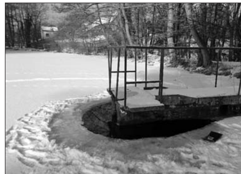
Obsekané výpustné zařízení od ledu II
